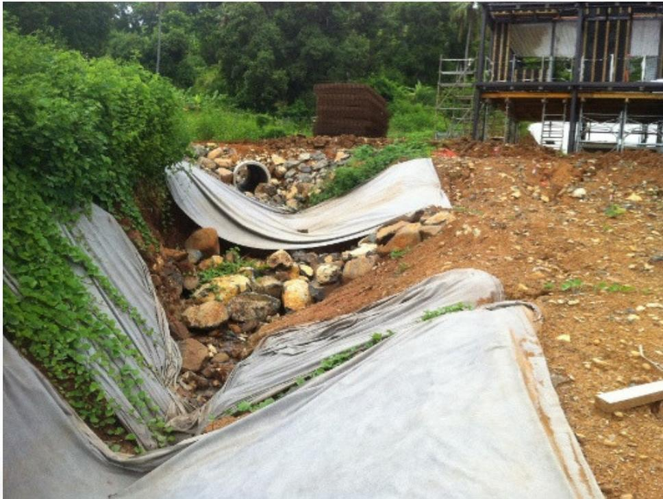
Les seuils anti-érosion semi-perméables sont utiles dès que la vitesse des écoulements superficiels doit être réduite, notamment :
