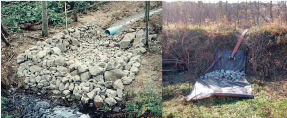
Choisir le dispositif en fonction de leur capacité à résister à l'érosion, du potentiel érosif du sol, du débit, de la pente, des enjeux en aval, de la place disponible et de la durée du rejet
