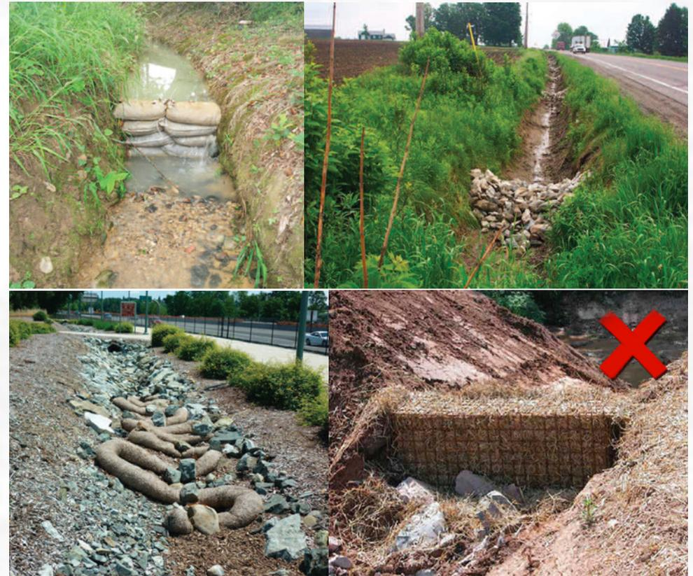
Paille décompactée dans un cadre métallique : ce dispositif crée un effet de seuil qui à terme, peut pousser les eaux à les contourner en érodant les talus sur le côté. Ils perdent alors toute leur efficacité.
